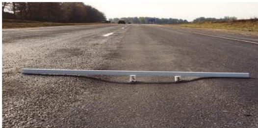
Рис. 8. Колейность (деформация дорожного покрытия (одежды) в виде продольных борозд различной глубины, образующихся по полосам наката)
