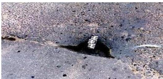
Рис. 9. Выбоины (разрушения дорожного покрытия в виде углублений разной формы с резко выраженными краями)
