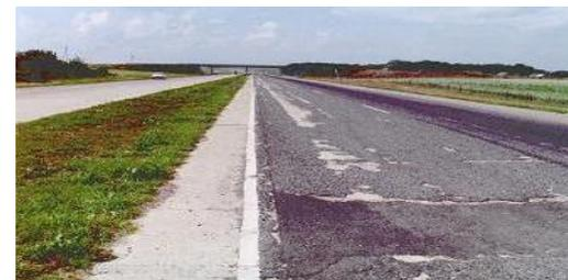
Рис. 11. Выкрашивание поверхностной обработки
