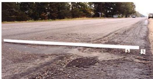
Рис. 10. Разрушение кромки
