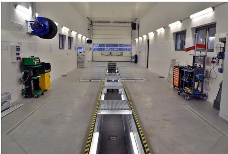
Рис.8.13 Линия проведения технического осмотра автомобилей на диагностической станции.
